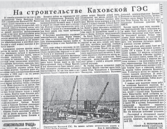
Строительство Каховской ГЭС. На снимке: работы по монтажу бетона в котловане шлюза.
