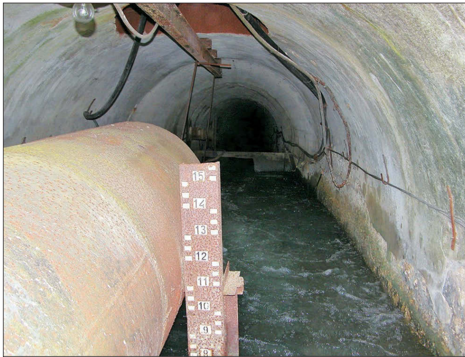
Водовод - длинный тоннель, по которому перемещаться можно только с фонариком. Тут всегда бурлит вода.
