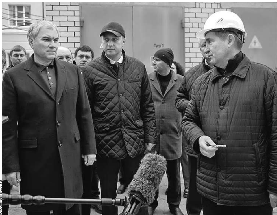
Вячеслав Володин оценил, как идет строительство противотуберкулезной больницы в Саратове. Она рассчитана на 453 места и состоит из восьми корпусов. Сейчас диспансер ютится в дореволюционном здании. Уже в марте планируют сдать объект под ключ.
