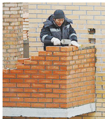
Возводить дома застройщики будут без денег дольщиков.
