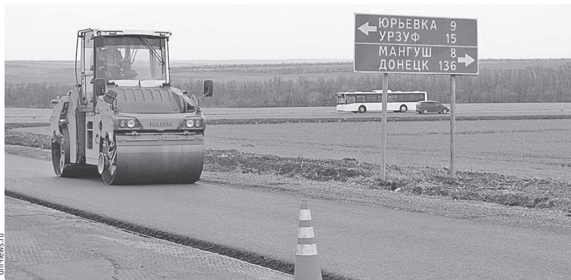
Дорогу, которая ведет в Крым через новые регионы, ремонтируют круглые сутки.
