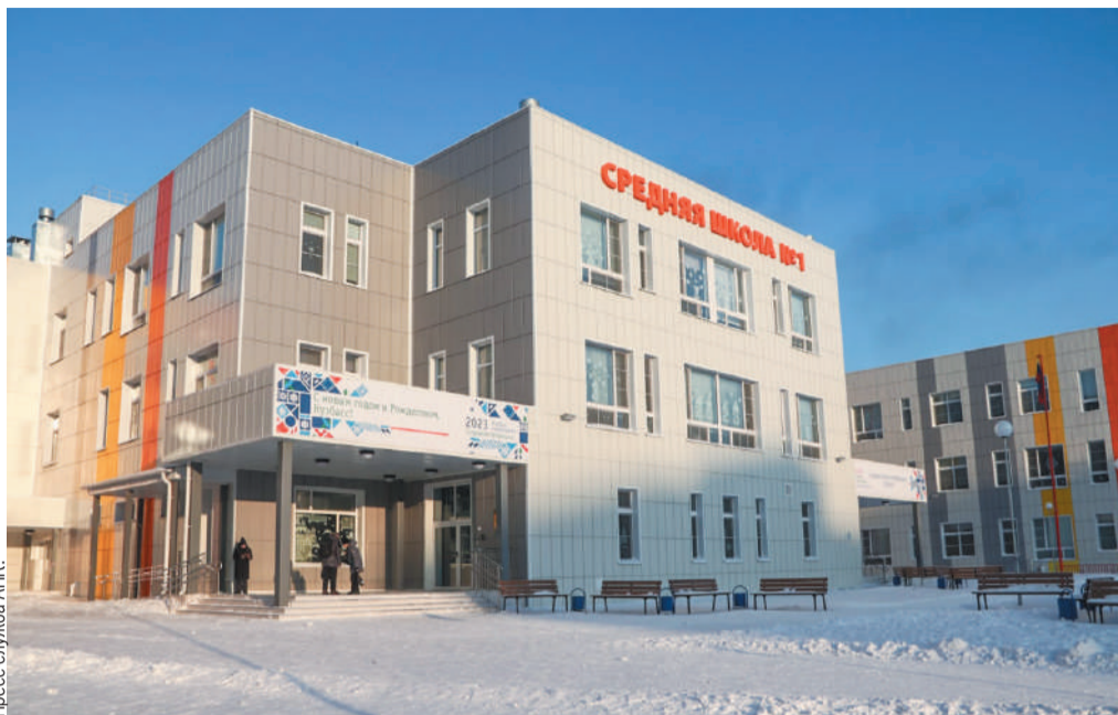
В школе №1 Анжеро-Судженска было холодно из-за того, что не хватало мощности котельной, обогревавшей еще и несколько многоквартирных домов.
