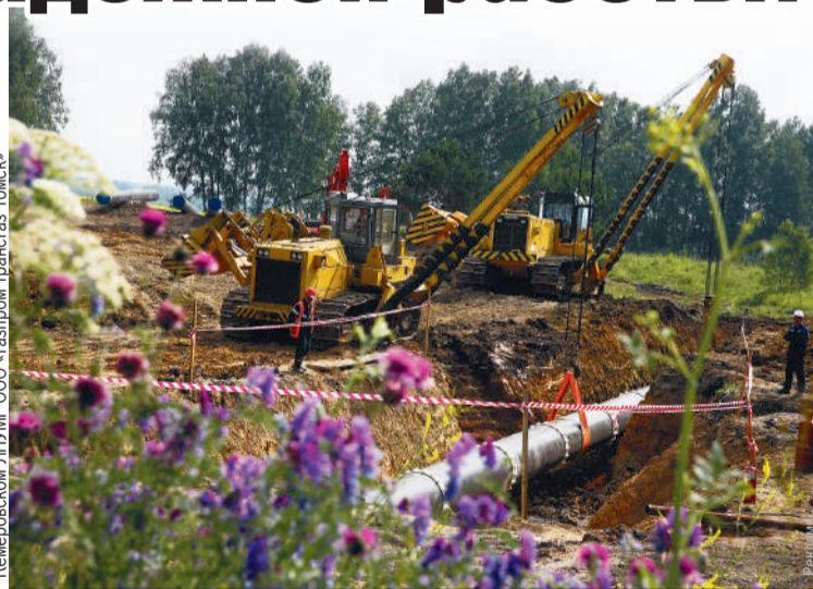
Ремонтные работы на автодорожном переходе. Лето 2018-го.
