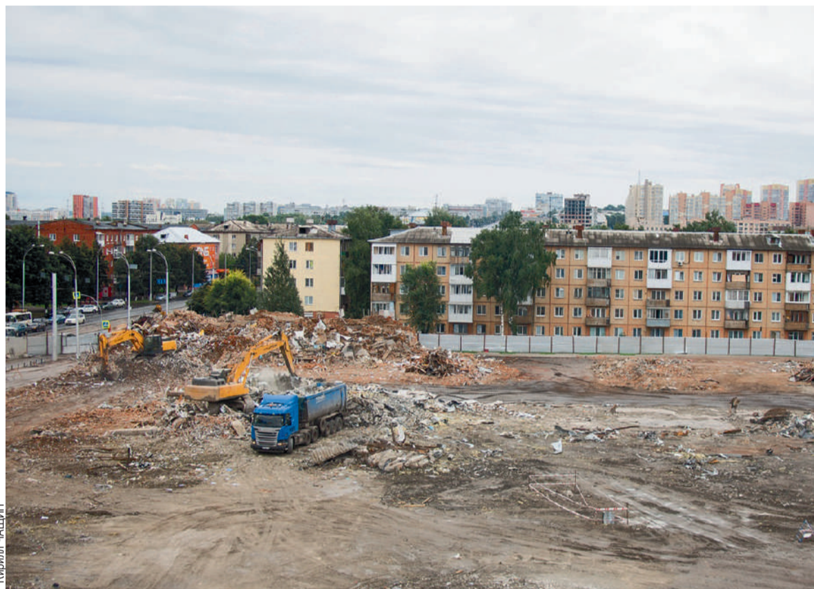
Здание «Зимней вишни», в котором произошел страшный пожар, полностью снесено, и сейчас с площадки вывозят строительный мусор.
