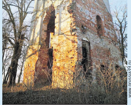
Частично сохранились башня и стены.
