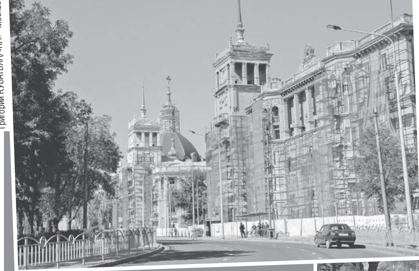
Мариуполь будто рождается заново. Там, где еще год назад стояли руины (фото справа), сейчас - строительные леса.
