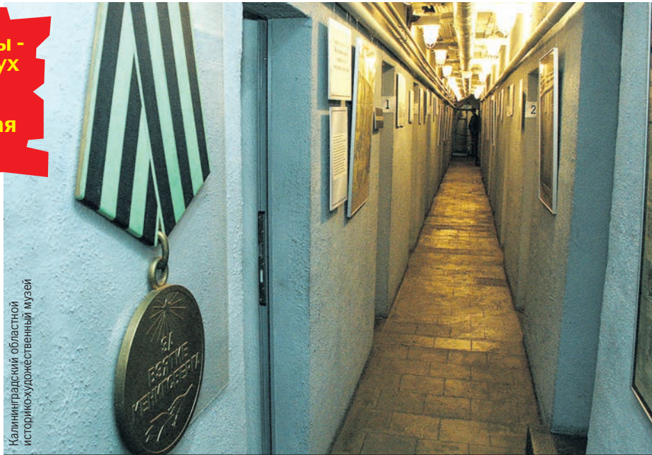
Узкий коридор и 21 помещение с двух сторон - такова конструкция бункера.
