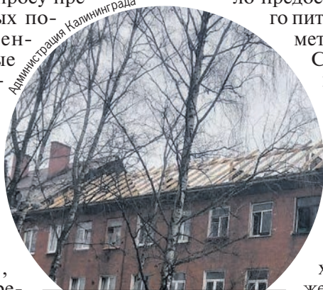
На крыше уже появилось основание.
