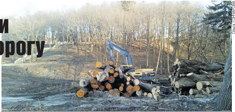
Теперь это строительная площадка, с которой планомерно и методично вывозят сотни бревен.
