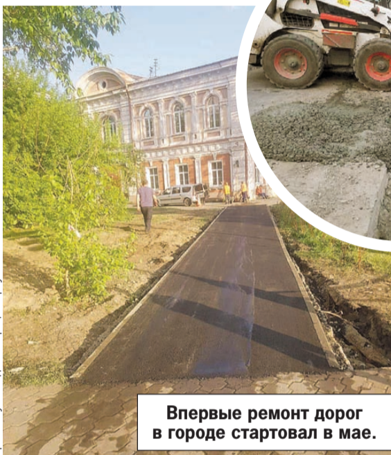
Проезжую часть чинят со стороны Правобережного округа.
