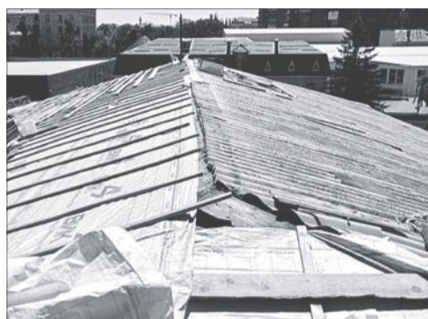
Мужчина проводил ремонтные работы на крыше во время дождя.
