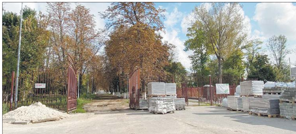
Реконструкция затягивается, но не отменяется.
