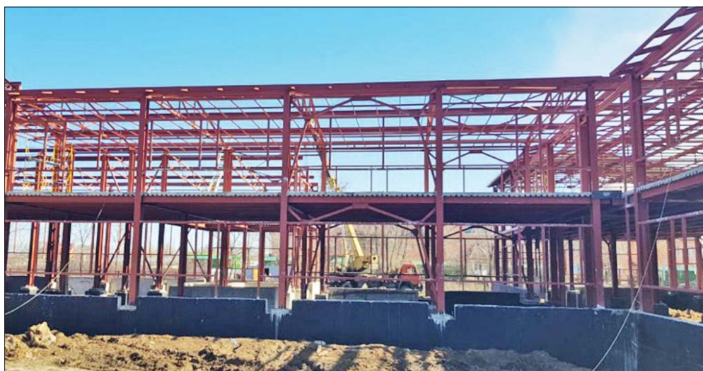
Школа на 200 мест появится в ст. Кривянская.
