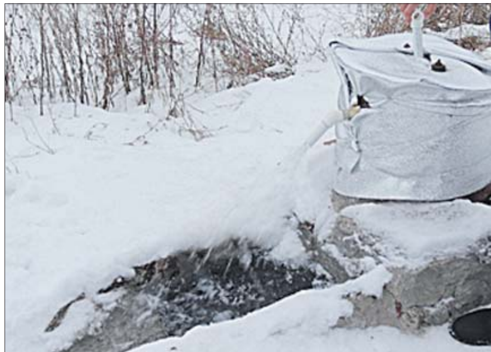
Колонка в посёлке Власовка восстановлена и утеплена. Фото с сайта http://shakhty-gorod.ru
