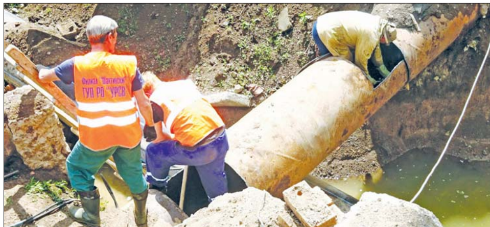
Май, 2018 года. На территории 3 ШДВ устанавливается заглушка диаметром 800 мм и идет монтаж трубы. Фото предоставлено Мариной Лениной.
