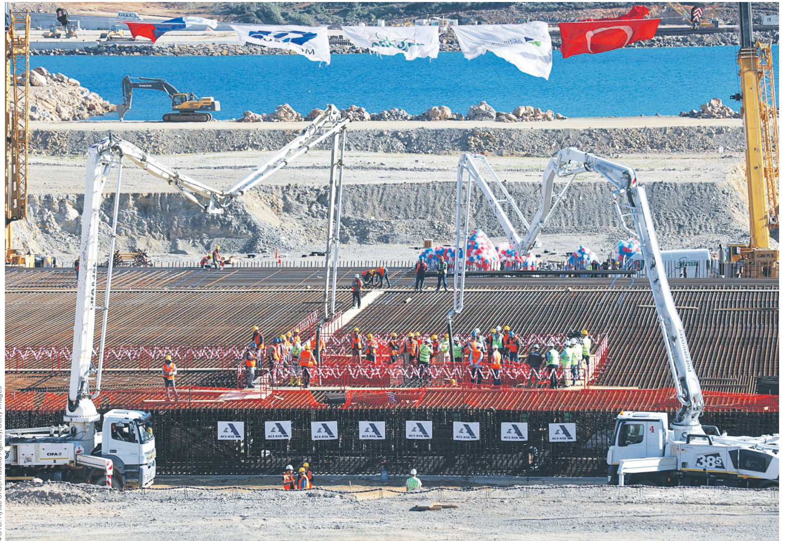
В церемонии начала строительства первого энергоблока АЭС «Аккую» приняли участие по видеосвязи президенты Турции и России. По обещаниям лидеров обеих стран первый энергоблок должен быть запущен в 2023 году
