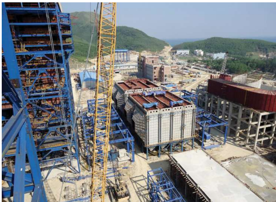
Монтажные работы электрофильтра ТЭС «Вунг Анг 1». Вьетнам.
