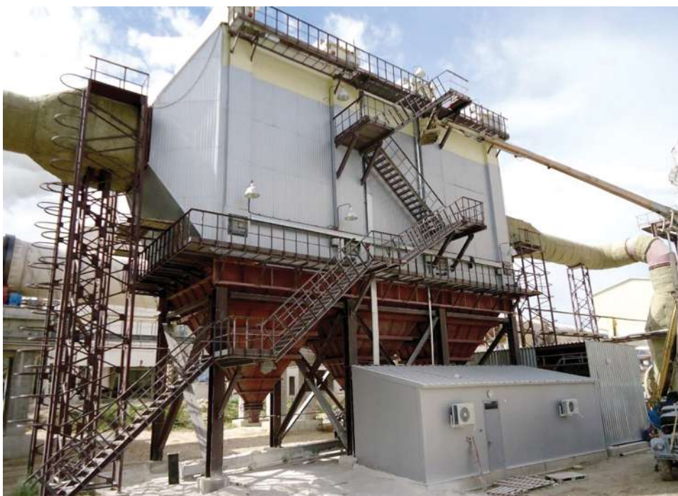
Электрофильтр четвертого поколения в сборе.
