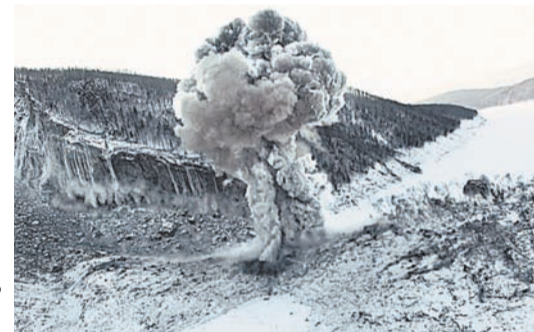
Начало подрывных работ на реке Бурее. К месту работ доставили 470 тонн взрывчатки, январь 2019 г. А хватило бы пары «чистых» ядерных взрывов.
