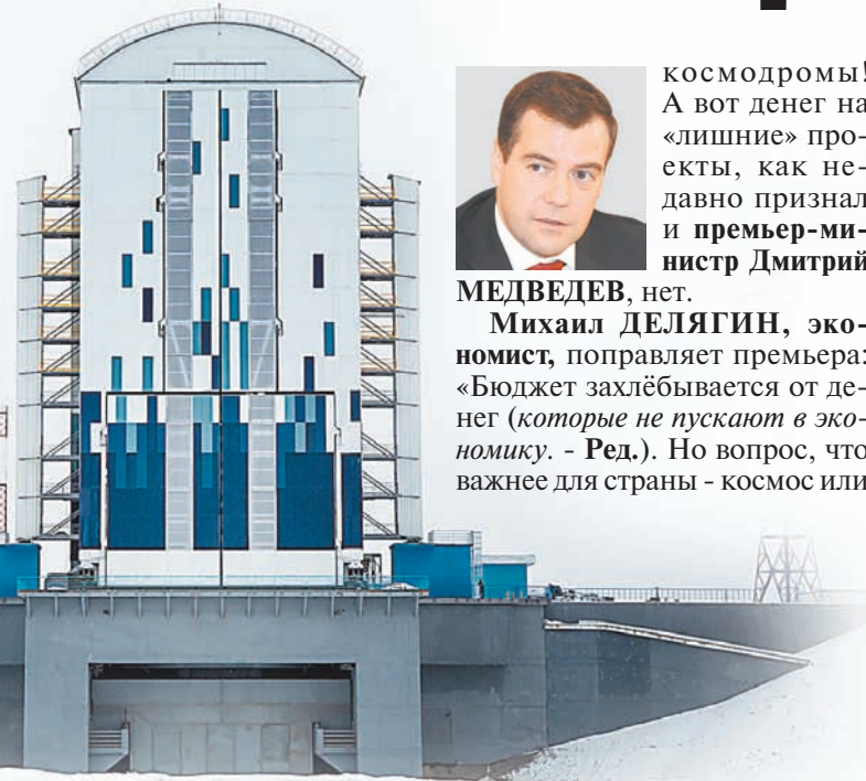
Стартовый стол и мобильная башня обслуживания внешне готовы к пуску.
